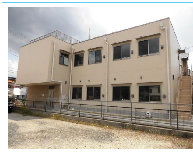
居室と非常階段(東側から)
